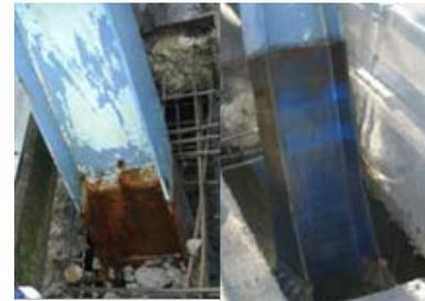
図 14 スtrandシートによる橋梁鉄鋼部材の補修例（左：補修前、右：補修後）
